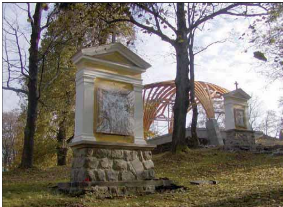
Výstavba nového venkovního pódia na Svatém Hostýně
