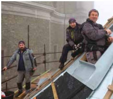
Přiložením posledního dílu nové plechové střechy završili klempíři renovaci kaple sv. Jana Sarkandra. Výsledek práce a zručnosti řemeslníků a restaurátorů čeká v nové poutní sezóně na vaši návštěvu.
